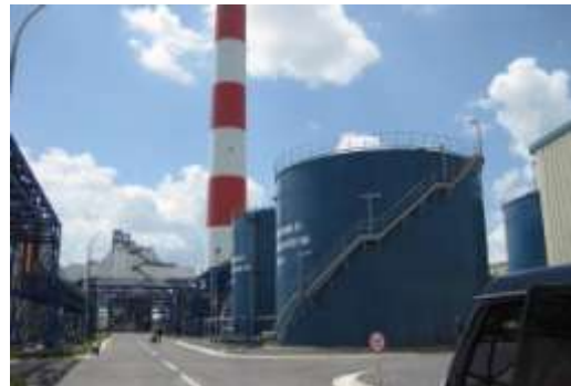
Lọc nước nhà máy điện Ô môn
