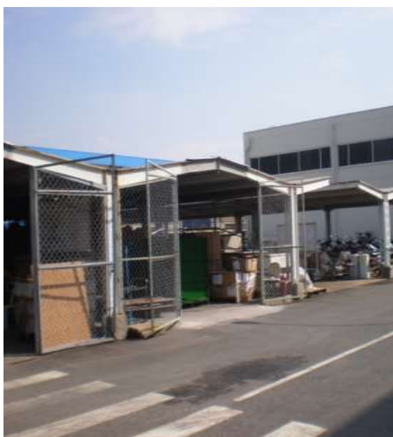
Khu chứa chất thải nguy hại trong nhà máy
