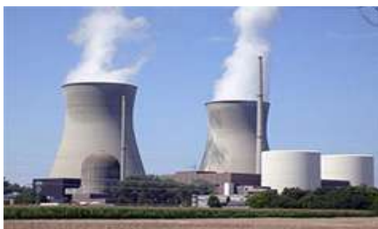
Nhà máy nhiệt điện Công Thanh
