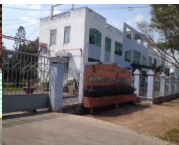
Nhà máy Pin-ắc quy Đồng Nai
