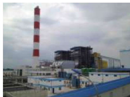
Nhà máy nhiệt điện Mạo Khê 2
